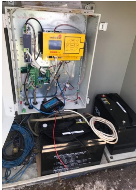
รูปแสดงการเปลี่ยนและติดตั้งแบตเตอรี่เพิ่มเป็น 2 หม้อ
