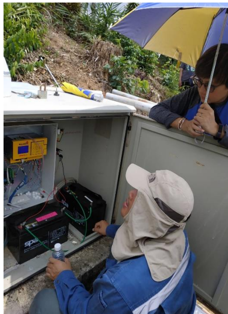
รูปแสดงการเปลี่ยนและติดตั้งแบตเตอรี่เพิ่มเป็น 2 หม้อ
