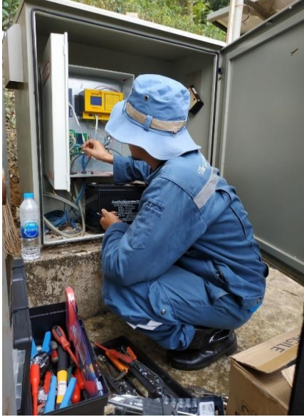
รูปแสดงการตรวจสอบสภาพการทำงานของเครื่องมือและอุปกรณ์
