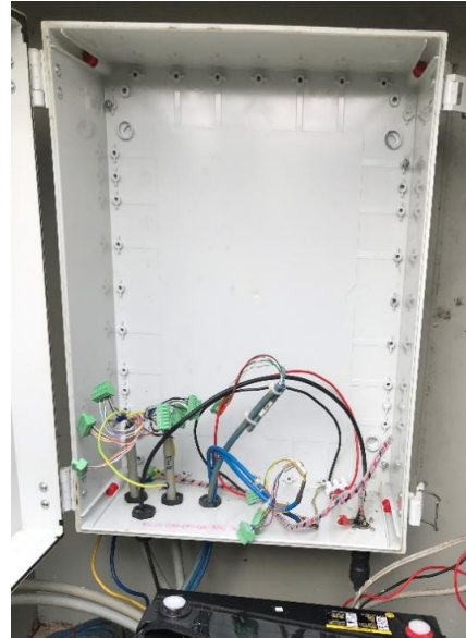
รูปแสดงการถอดเครื่องมือและอุปกรณ์
