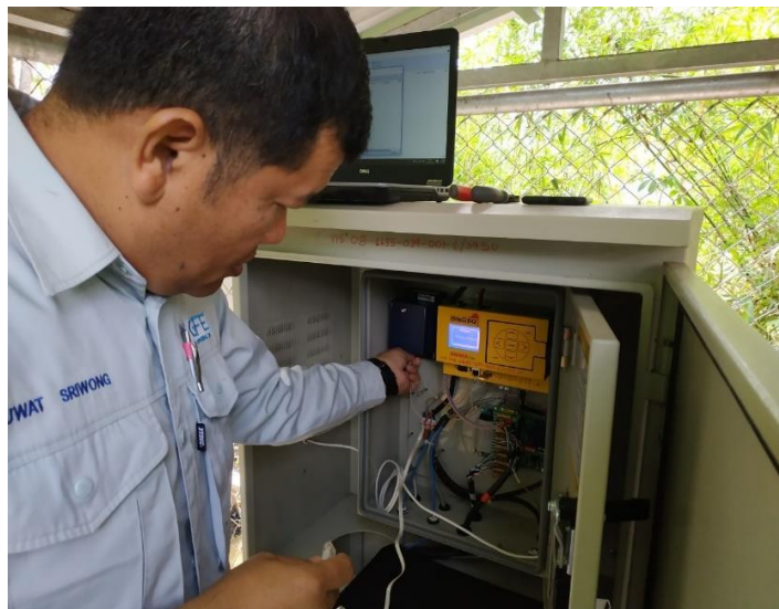
รูปแสดงการถอดเครื่องมือและอุปกรณ์
