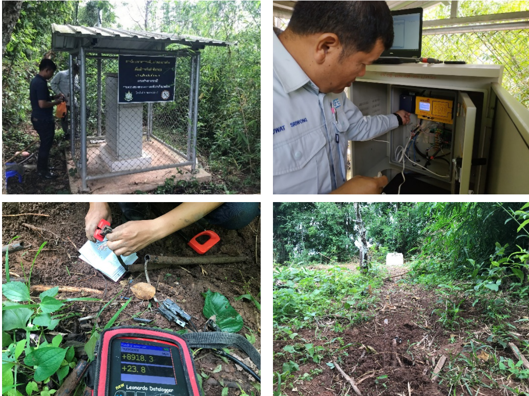
รูปที่ 4-7 รูปถ่ายการซ่อมแซมหรือเปลี่ยนเครื่องมือตรวจวัดฯ ณ พื้นที่บ้านห้วยล้อม หมู่ที่ 5 ตำบลภูฟ้า อำเภอป่อเกล้า จังหวัดน่าน
