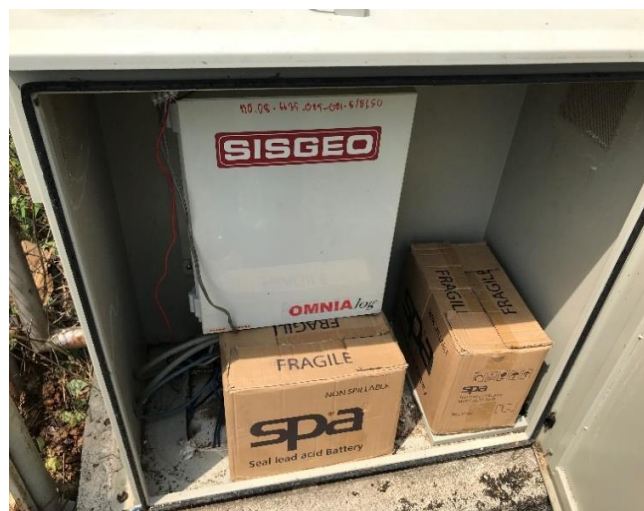
รูปแสดงการเปลี่ยนและติดตั้งแบตเตอรี่เพิ่มเป็น 2 หม้อ
